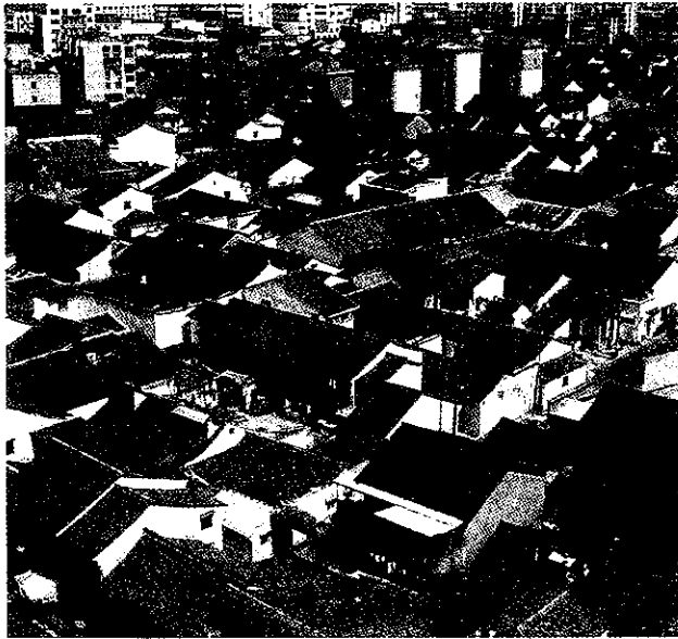
完成修缮的书圣故里历史街区(市建设局提供)
