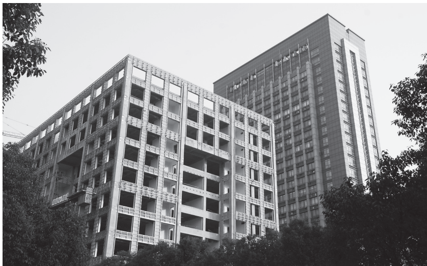
绍兴高新区科创大厦二期工程结顶
