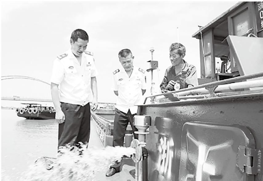
上虞港航货船污水柜安装
