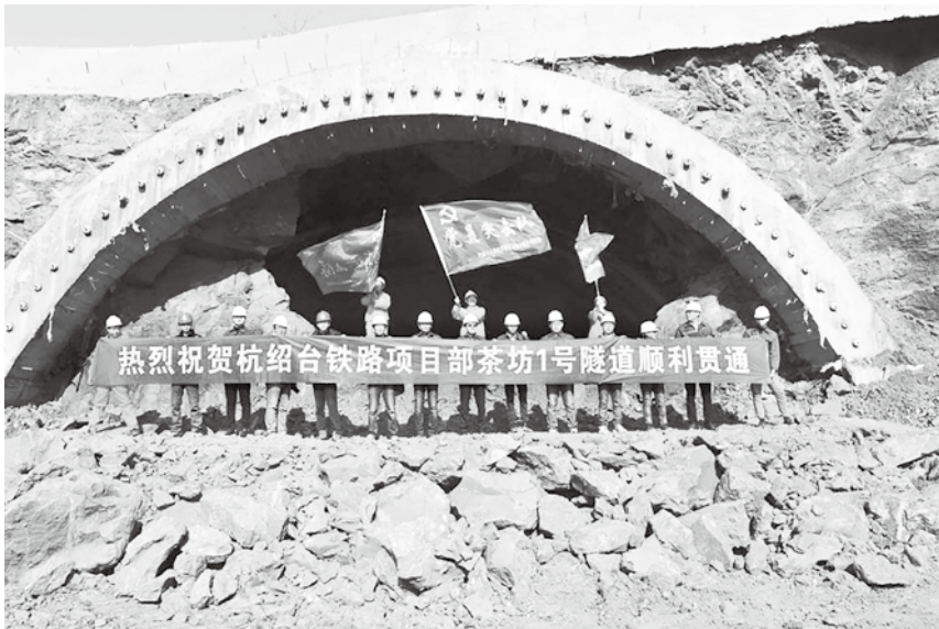
12 月 18 日,杭绍台铁路全线首条隧道茶坊 1 号隧道贯通。(市交通运输局提供)
